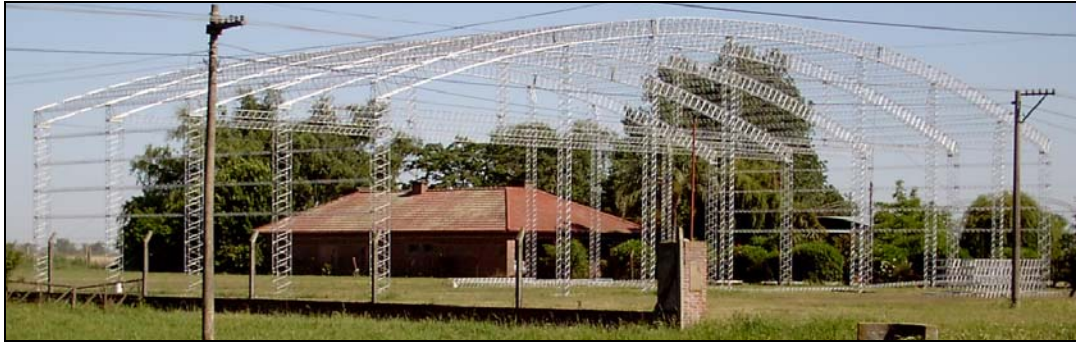
Figura 1: Vista de una estructura típica durante su construcción.
