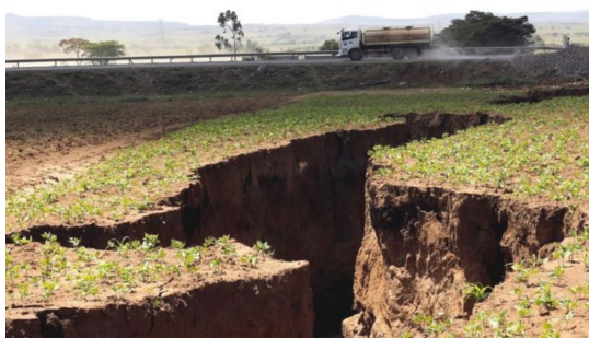
Figura 1. La carretera que une Narok con Nairobi fue atravesada por una grieta (de 15 m de profundidad y hasta 20 m de ancho) que se abrió en marzo de 2018 en el suroeste de Kenia. Fuente: BBC Mundo (2018)
