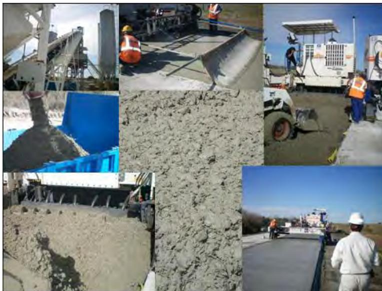
*Figura 110. Empleo de macrofibras sintéticas en un whitetopping adherido empleado para la reparación y refuerzo de la ruta 24 en la República Oriental del Uruguay. Elaboración propia.*
