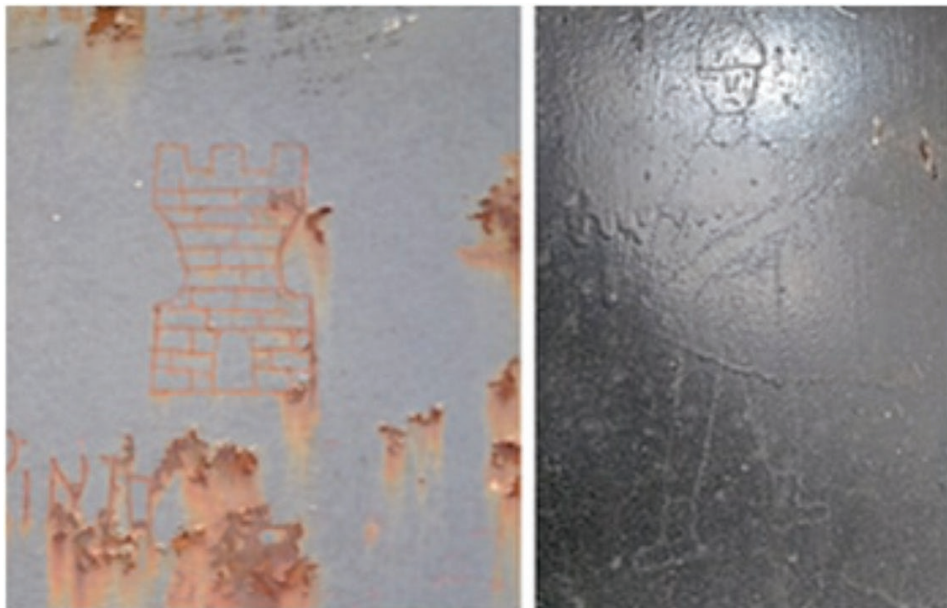
Figura 7: Graffitis registrados en el interior del tanque de agua con simbología vinculable al Ejército Argentino.
