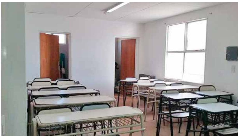
Fotografía: Carla Andrea Villagrán. Aula habilitada en hall de entrada auxiliar. Al fondo se observan dos baños que funcionan actualmente como depósitos.
