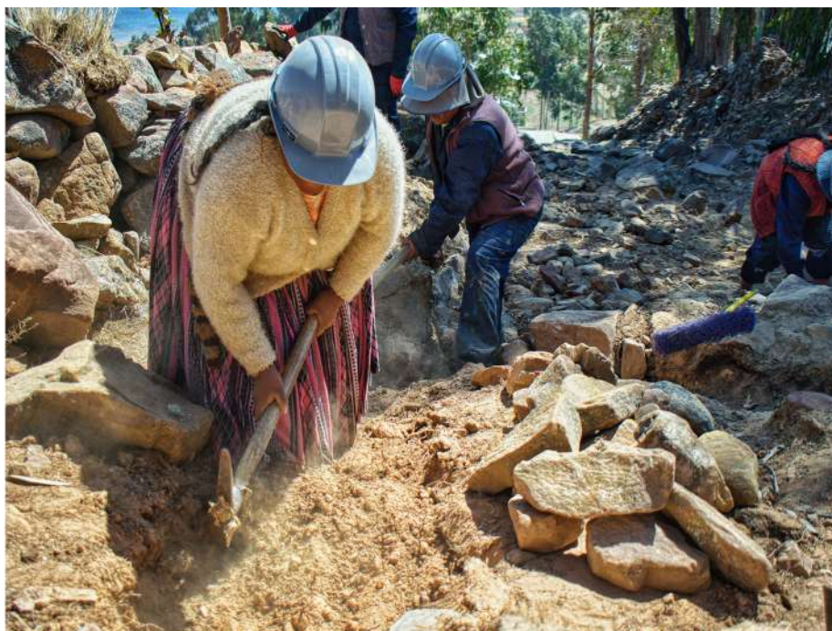
Figura 6. Preparación del terreno y selección de piedras para la reposición de la calzada. Fotografía de los autores.
