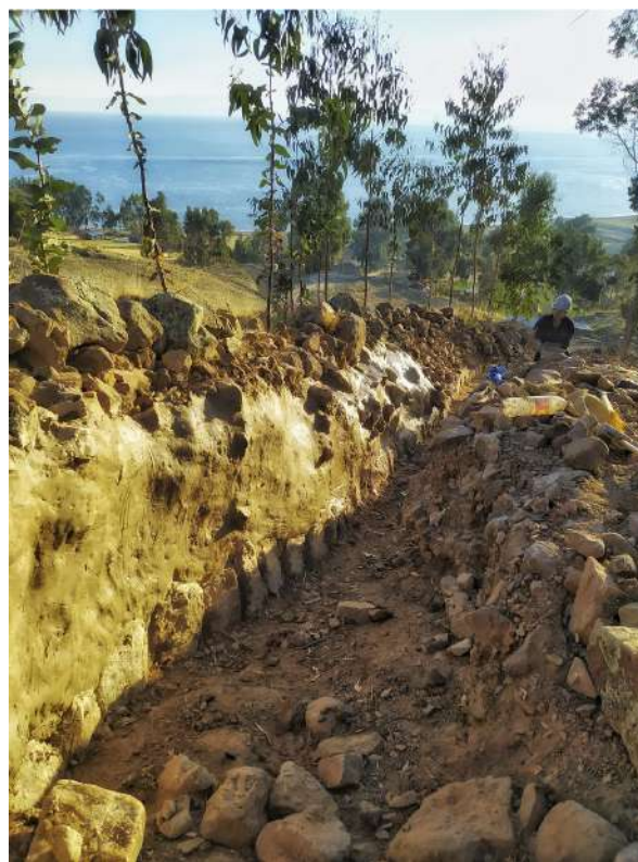
Figura 4. Vista del muro impermeabilizado con greda local. Fotografía de los autores.
