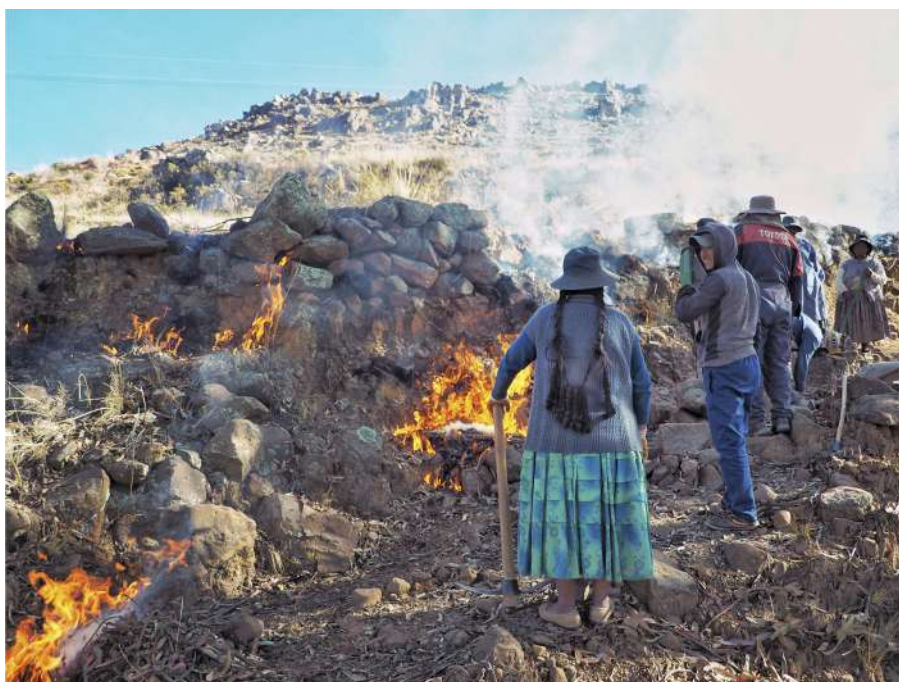
Figura 8. Proceso de limpieza del camino mediante quema. Fotografía de los autores.
