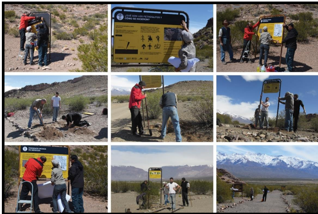
Figura 5: Actividades de colocación de cartelería, setiembre 2015.
