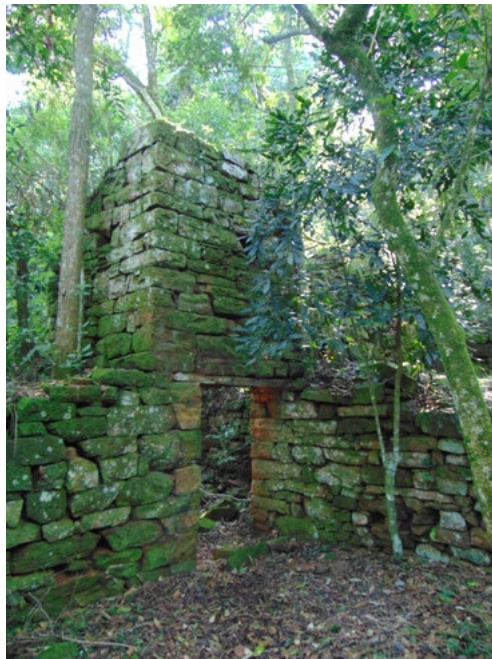
Figura 4. Entrada a la planta baja a la Estructura II, los sillares de piedras están trabajados aunque sin elementos de unión. Los dinteles y carpinterías de puertas y ventanas son hierros industriales (Fotografía de A. Igareta).
