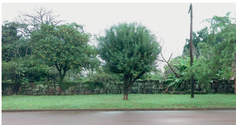
Figura 4. Muro de rocas itacurú que forma parte del frente de una vivienda particular.
