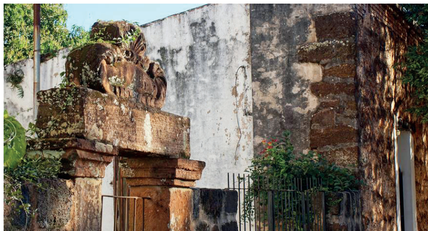
Figura 3. Pórtico con dintel monolítico. Actual frente del predio del cabildo.
