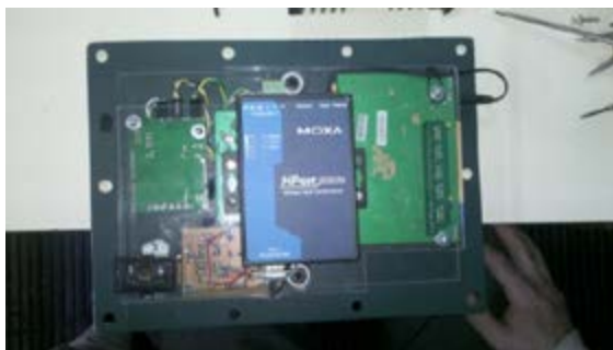
Figura 8: Alojamiento del sistema de control electrónico.
