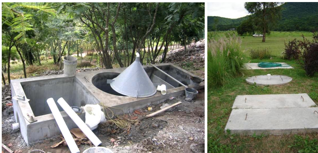
Figura 3. Sistema STAR en construcción (izquierda) y en operación (derecha). El sistema de la izquierda es una versión compacta del diseño original, desarrollada por arquitectos locales. Fotografías de Luis F. Rengifo (izquierda) y Walter A. Tejerina (derecha)
