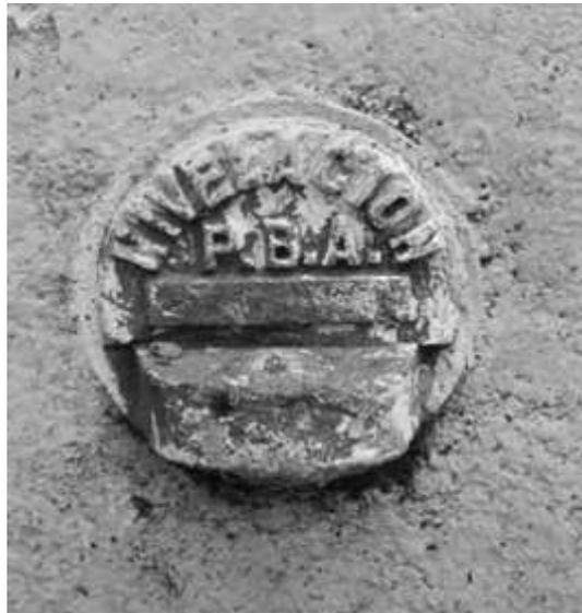
**Figura 3.** Punto fijo ubicado en la cara sudeste del edificio de Química.
