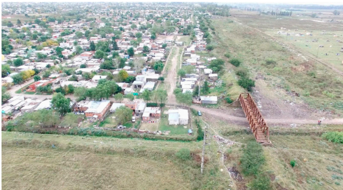
Figura 5: El barrio Puente de Fierro aéreo
