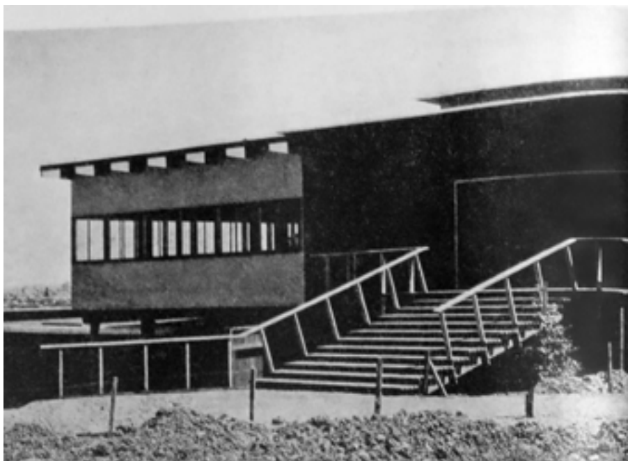
Figura 1. Ejemplos de viviendas y edificios comunitarios construidos durante la guerra en la Costa Oeste. Cafetería en Vallejo, California, William Wilson Wurster.
