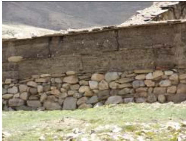
Figura 9 – Muro de tapial con sobrecimiento de piedra en la comunidad de San Francisco, Salta
