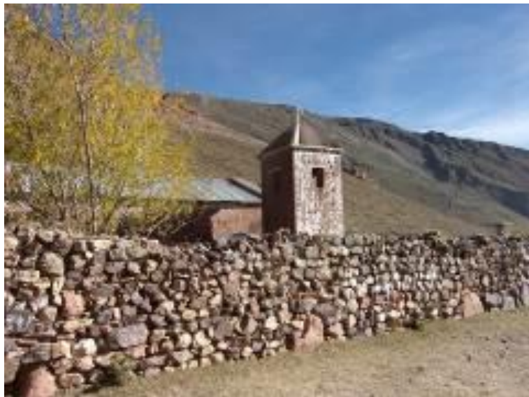
Figura 11 – Muro de cerramiento con pirca seca, en la Iglesia de la comunidad de Campo de la Paz, Salta
