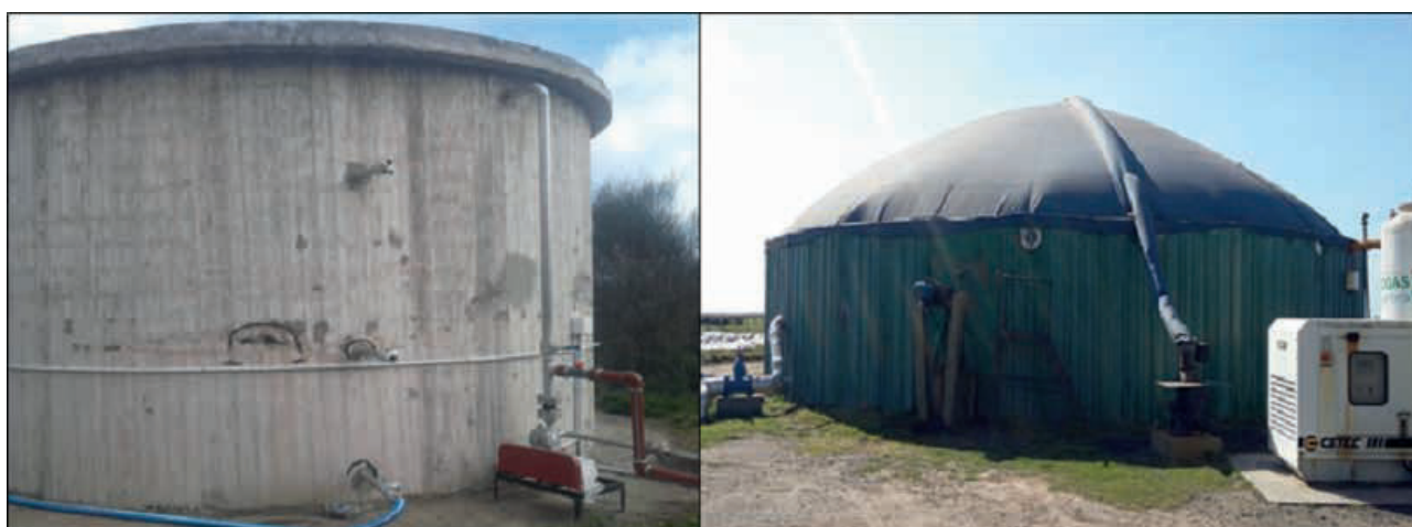
Figura 2 | Izquierda, biodigestor en Los Pinos (Balcarce); derecha biodigestor en Carlos Tejedor. Fuente: Elaboración propia. Trabajos de campo realizados en 2017 y 2019.
