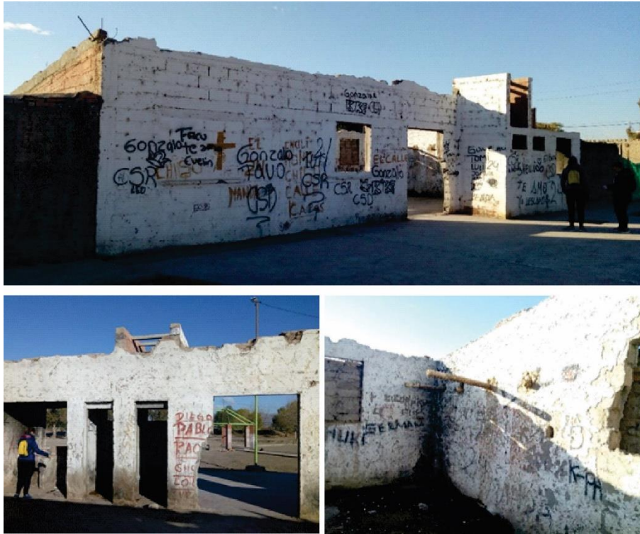
Figura 6. Relevamiento físico del estado actual del edificio de la unión vecinal. Foto: equipo del PDTs, 2019.
