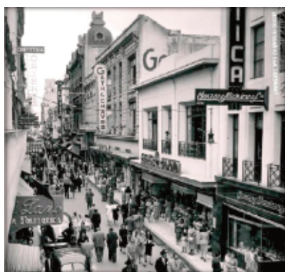
Imagen II. Calle 9 de julio antes de ser peatonal
