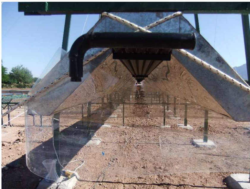
Figura 6.- Muestra el absorbedor colocado debajo de la estructura de soporte para ser elevado hasta su posición final
