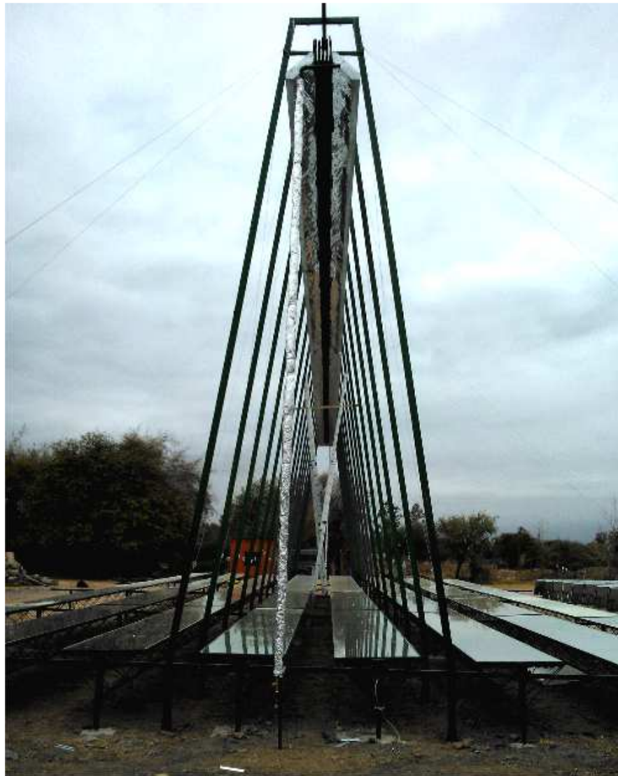
Figura 3. - Se aprecian en detalle los espejos y sus soportes con la casilla de control al fondo
