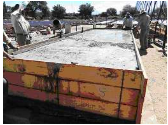
Figuras 9 y 10. Muestra la instalación de los caños y el posterior llenado de hormigón en el acumulador
