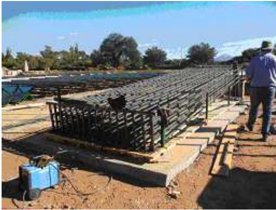
Figuras 9 y 10. Muestra la instalación de los caños y el posterior llenado de hormigón en el acumulador
