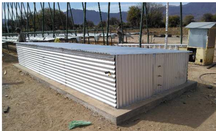
Figura 11.- Muestra al acumulador terminado con su protección de chapas contra la humedad.
