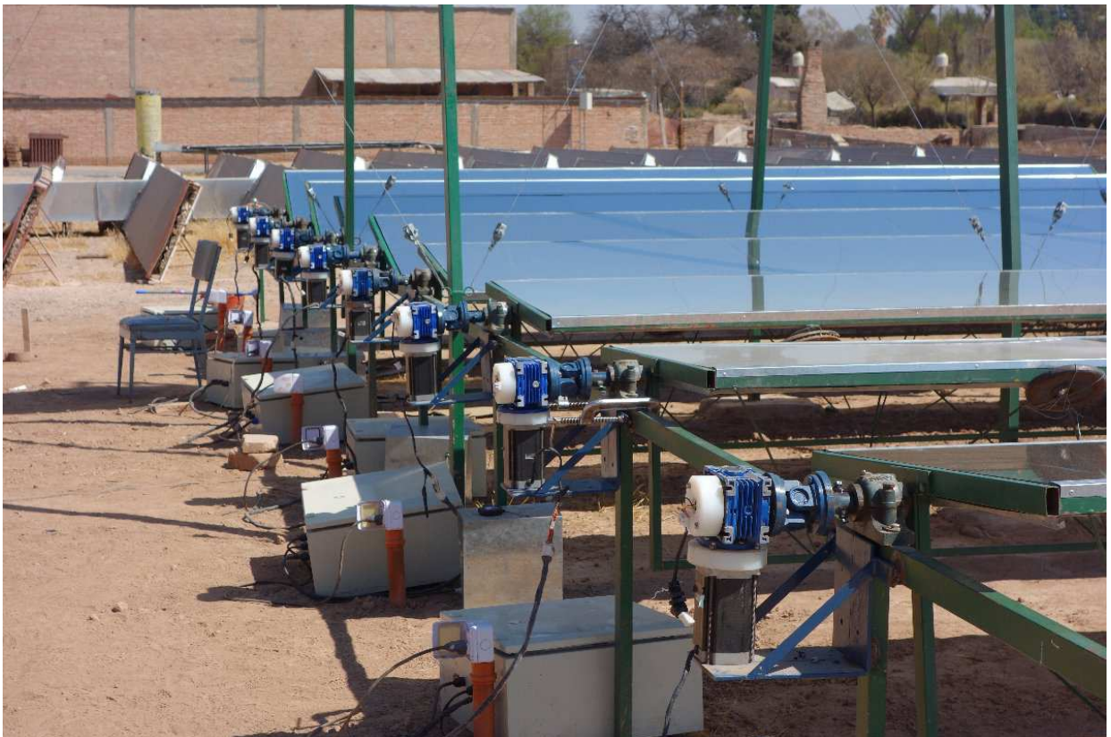
Fig. 13.- Conjunto de 8 motores y sus cajas de control conectados a las 8 filas de espejos
