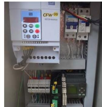
Fig. 5. Tablero de PLC y reguladores
