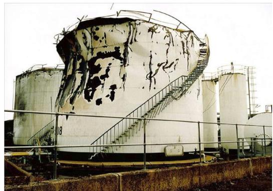
**Figura 3:** Falla de un tanque bajo presiones debidas a la explosión del 11 de Diciembre de 2005, Buncefield, Inglaterra. (Buncefield, 2008)
