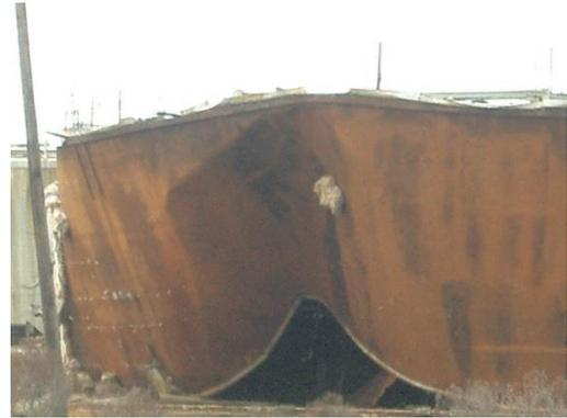
**Figura 2:** Falla de un tanque en una planta en Port Sulphur, Luisiana, Estados Unidos, debido a acción directa de viento durante el Huracán Katrina en 2005 (Godoy, 2007).
