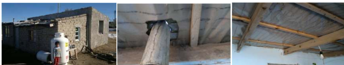
Figura 1: Vivienda de adobe, mampostería y chapa. Figura 2. Infiltración entre techo y salida de gases. Figura 3: Techos de chapa y polietileno con condensación
