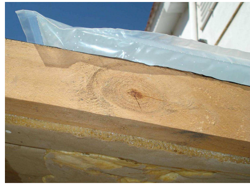
Figura 5: Aislación de poliuretano y marco de madera.
