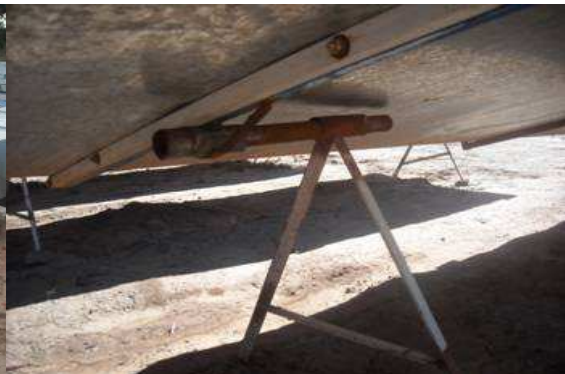
Figura 3: Detalle del montaje basculante de los colectores
