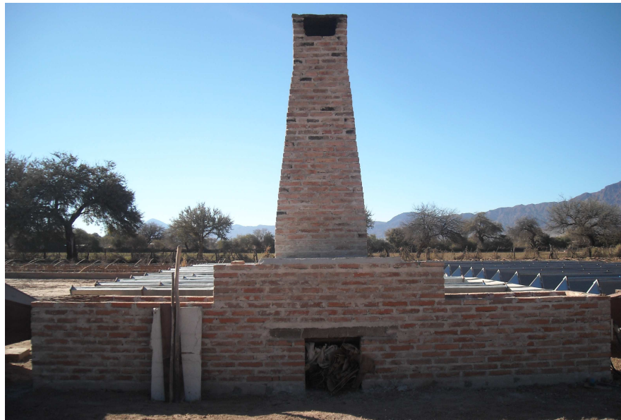
Figura 4: Quemador de leña con banco de tubos incorporado
