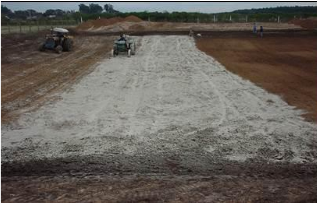
Figura. 3. Impermeabilización del área del humedal con bentonita.
