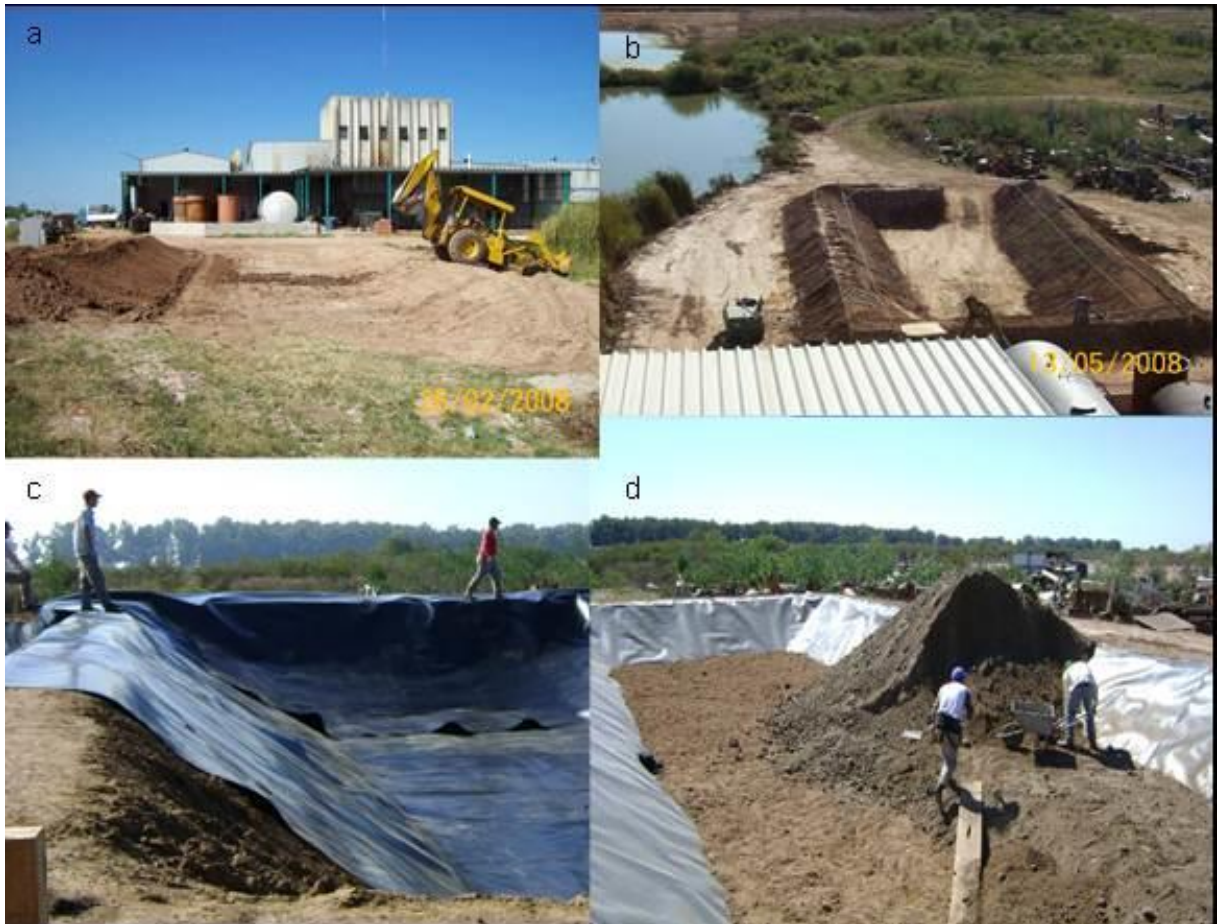
Figura. 8. Etapas de la construcción del humedal. Trabajos de movimiento de suelo: excavación, perfilado y compactación de taludes laterales (a y b), impermeabilización con geomembrana (c) y agredado de tierra para sustrato de las plantas (d).
