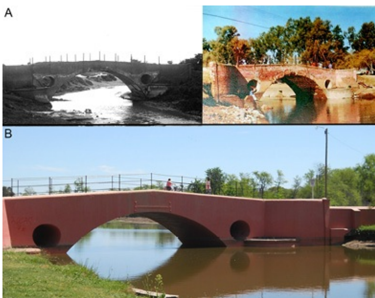
Figura 20. A. Puente Viejo antes de la restauración.
