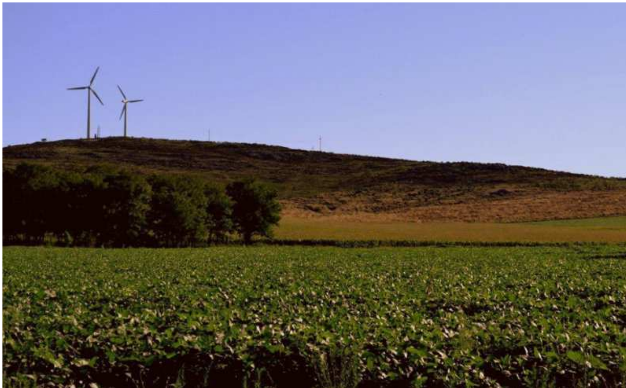
Foto N° 2. Parque Eólico Cooperativa Rural Eléctrica Tandil-Azul Limitada (CRETAL) compuesto por dos aerogeneradores de eje horizontal con 800 Kw de potencia, emplazado a 280m en el Paraje La Vasconia del partido de Tandil (2014).
