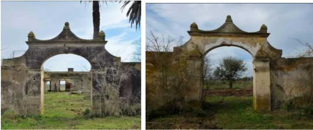
Figs. 13 y 14. Pórtico del Este, mirando hacia adentro y afuera del patio.
