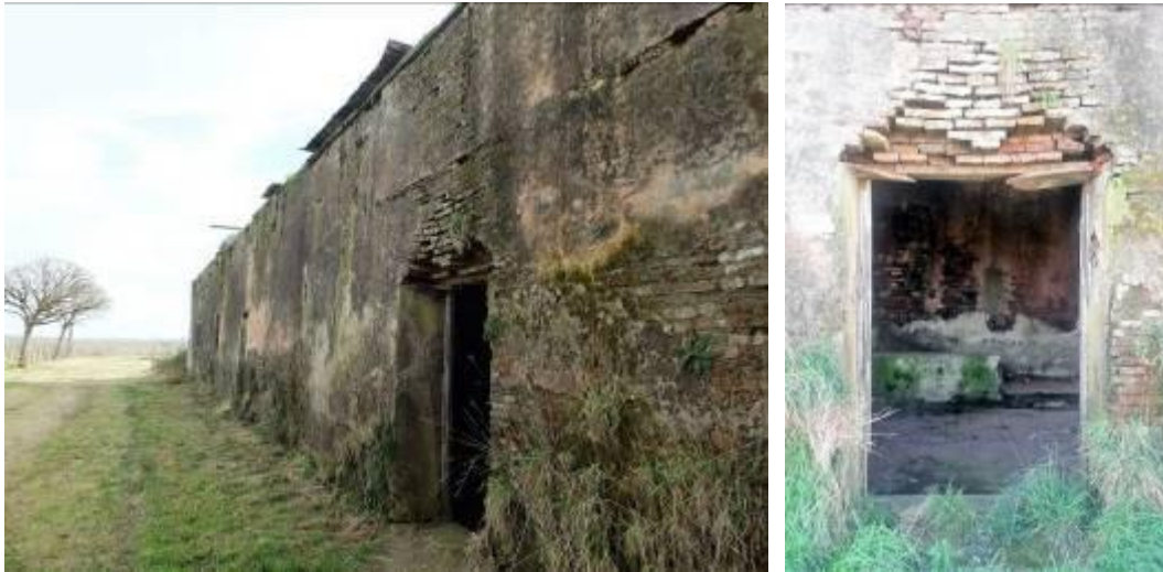
Figs. 19 y 20. Fachada al norte: la más antigua; nótese la falta de ornamentación, la evidencia de una galería exterior y la falta de dinteles adecuados.
