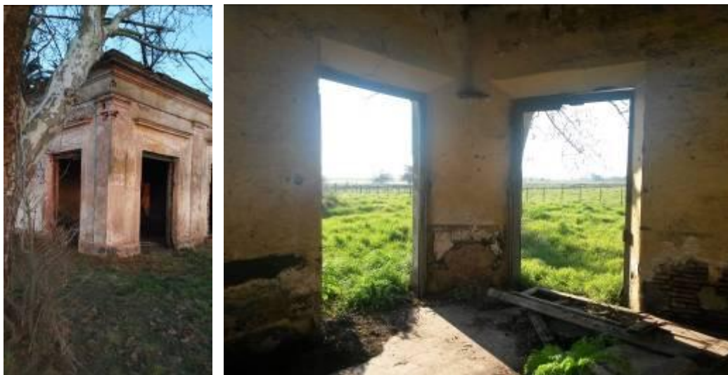
Figs. 30 y 31. Puerta de esquina del salón; nótese la excelente solución del soporte del ángulo.
