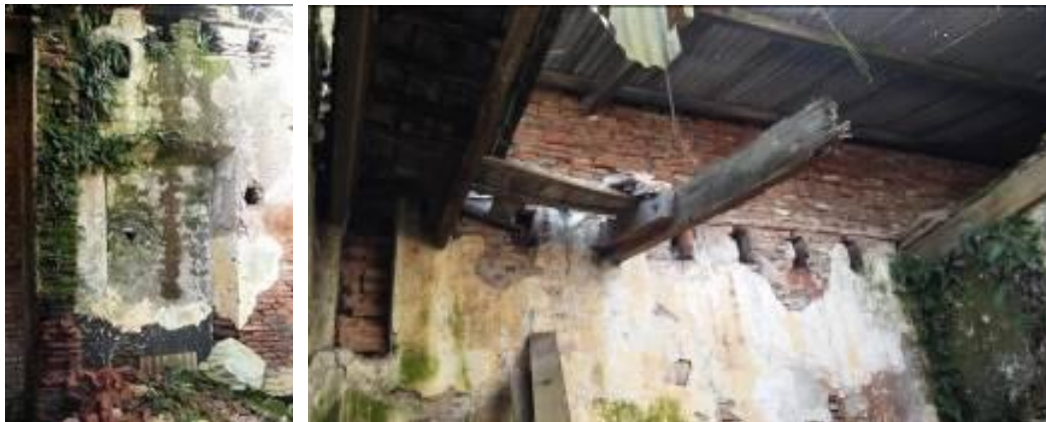
Figs. 21 y 22. Puerta abocinada en la casa más antigua y evidencia del techo original y sus modificaciones.
