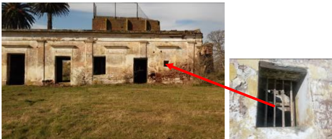
Figs. 8 y 9. Ventana de la considerada "cárcel" en el sector antiguo del edificio, donde funcionaron las autoridades entre 1893 y 1894. Se hace evidente que los arreglos del frente son posteriores.
