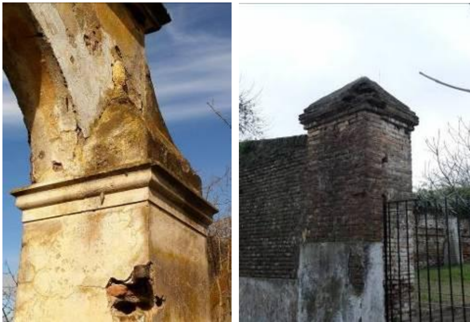
Figs. 15 y 16. Pilar de la primera época del pórtico, luego cortado para colocar la cartela decorada. Compárese con un pilar de la Casa Casco en Chascomús.
