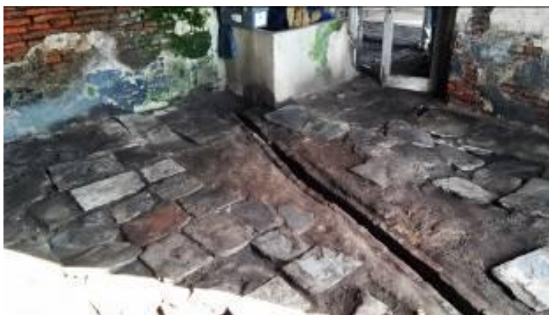
Fig. 29. La habitación una vez limpia, recuperadas las piedras y limpias las paredes. En épocas recientes se le colocó un bebedero para agua para un caballo y un desagüe que alteró el piso.
