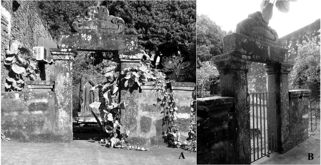
Figuras 11. A: pórtico con dintel monolítico, en el antiguo Cabildo jesuítico de Concepción con presencia de cobertura vegetal; B: el mismo pórtico sin presencia de vegetación, pero con las manchas blancas y verdes que siguen intactas.
