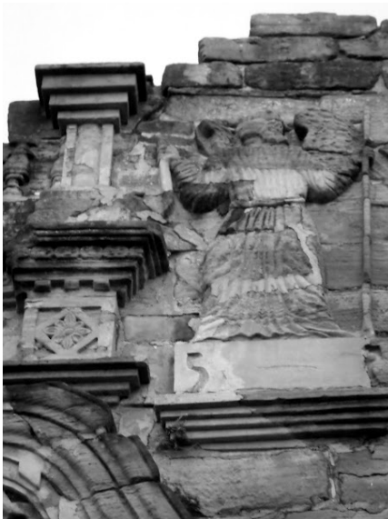
Figura 5. Reducción de San Ignacio Mini. Muro de estructura. En la ornamentación podemos observar una persona o ángel portando una bandera en la mano derecha, en alto relieve.
