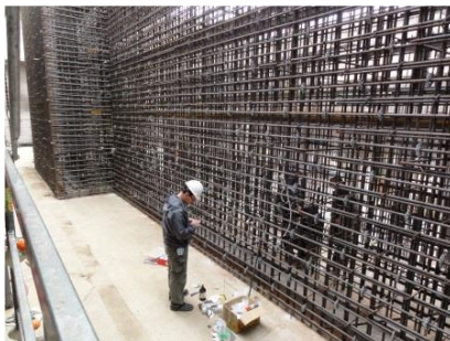
Figura 35. Sensores aplicados en estudio de corrosión del hormigón armado.
