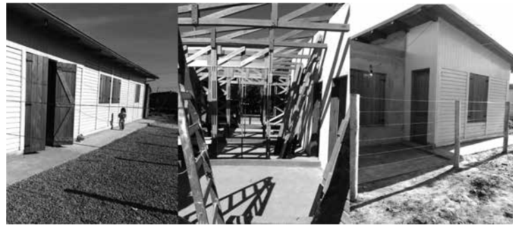
Figura 8. Finalización de la primera vivienda de Villa Cresto, Concordia, Entre Ríos (Argentina)
