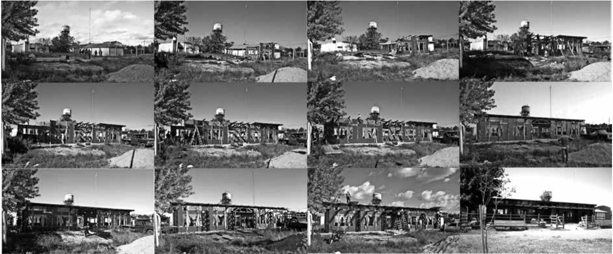
Figura 4. Proceso de montaje in situ de los componentes para el SUM prefabricados en taller
