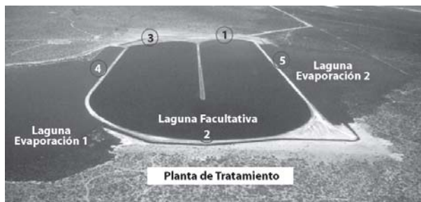
Figura 1. Sistema de tratamiento secundario de Puerto Madryn
