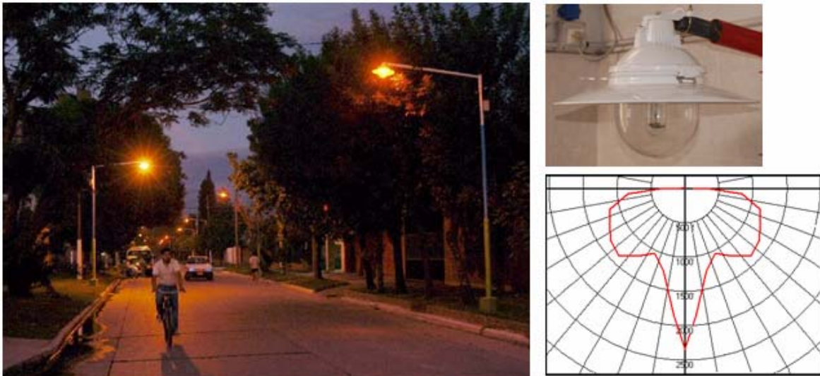
Figura 3.- Instalación de Alumbrado Público con Luminaria B (Enero del 2006)
