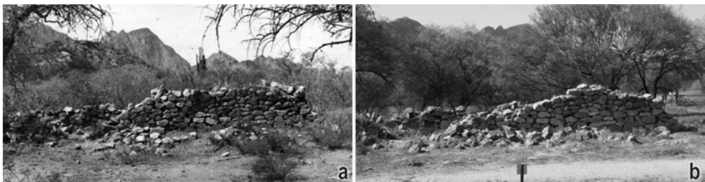
Figura 7. Segmento de la pared frontal de la kallanka 5; a: fotografía realizada por Weiser el 20 de noviembre de 1925 (MLP-Ar. Fotografías VIII° Expedición Arqueológica Benjamín Muniz Barreto a la Provincia de Catamarca, 1925/1926); b: fotografía realizada por nosotros el 19 de febrero de 2015 de la misma pared de piedra fotografiada por Weiser.
