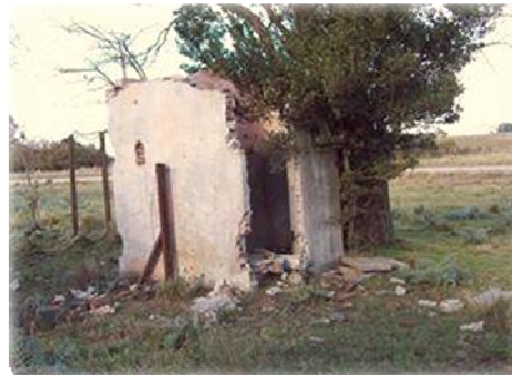
Imagen N° 11: Construcciones derruidas en Defferrari
