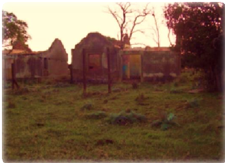
Imagen N° 10: Colonia ferroviaria destruida en Defferrari
