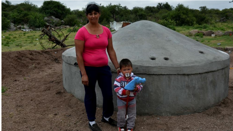
Foto 3: Cisterna para Almacenamiento de Agua. Fuente: Diario “ La Voz del Interior ”, 23/03/2015.
