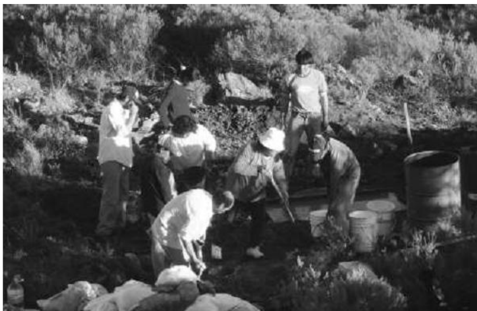
Foto 2: Proceso de trabajo para enterrar la “manguera” de las cisternas en el Departamento de Minas. Fuente: Acceder Al Agua , Barreda et. al. , 2009.
