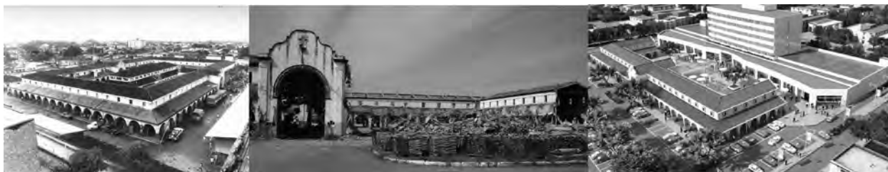
FIGURA 3. SECUENCIA FOTOGRÁFICA (DE IZQ. A DER.) DEL EX MERCADO DE ABASTO: MERCADO ORIGINAL, SU PROCESO DE DEMOLICIÓN, NUEVO PROYECTO COMERCIAL
