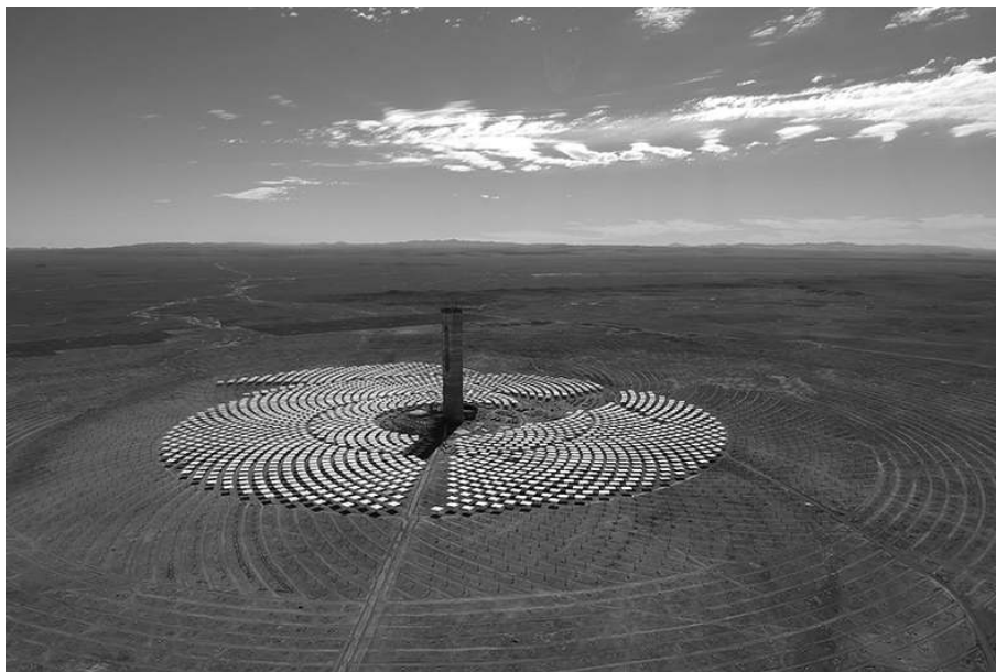
Photo 3a : Centrale solaire à concentration de Cerro Dominador (Atacama, Chili) a
