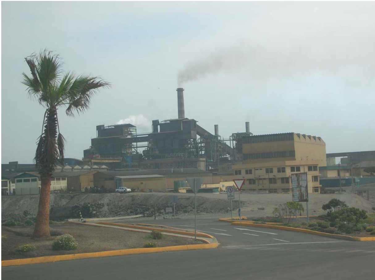
Photo N° 4 : Centrale thermique à charbon Norgener à Tocopilla.
