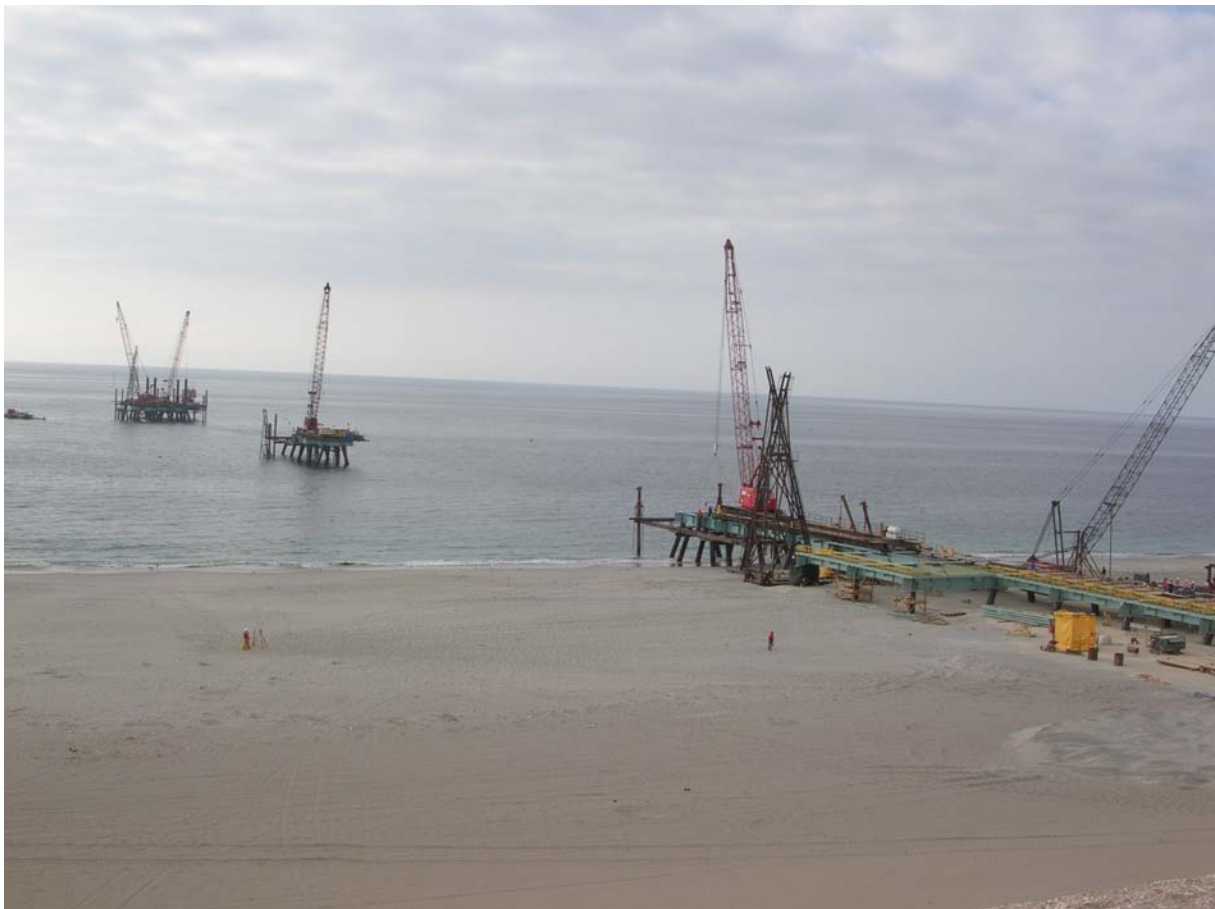
Photo N° 4 : Construction du terminal GNL de Mejillones (2008).
