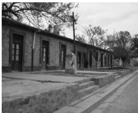
Figura 17: Pabellón de viviendas para solteros de la Estación Volcán en la provincia de Jujuy. Situadas sobre la línea Jujuy-La Quiaca. Fuente: Mónica Ferrari, 2009.
