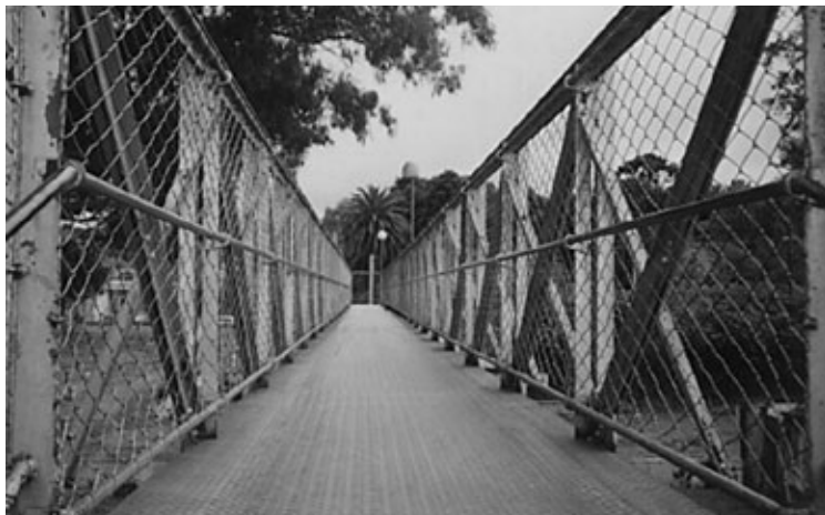
Figura 5: Puente peatonal prefabricado enteramente en hierro. Situado en la Estación Metán sobre la línea Tucumán – Salta. Fuente: Mónica Ferrari, 2002.
