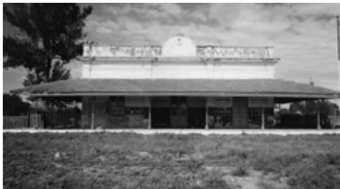
Figura 11: Bloque de Sanitarios de la Estación Andalgalá en la provincia de Catamarca. Situado sobre la línea Chumbicha – Andalgalá.
