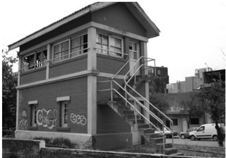
Figura 20: Cabina de señales de la Estación Tucumán Central Córdoba en la ciudad de San Miguel de Tucumán. Fuente: Mónica Ferrari, 2001.
