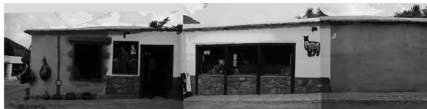
Fachada sobre Rivadavia
