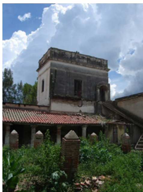
Figura 3. Vista del segundo piso de la casa.
