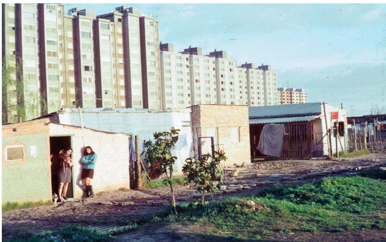
Figura 8. Villa La Lonja (5; delante) con el conjunto habitacional PAB "C" (Nágera) de fondo, circa 1968 (mi estimación). Fuente: Biblioteca y Archivo del Instituto de Vivienda de la Ciudad (ex Comisión Municipal de la Vivienda).
