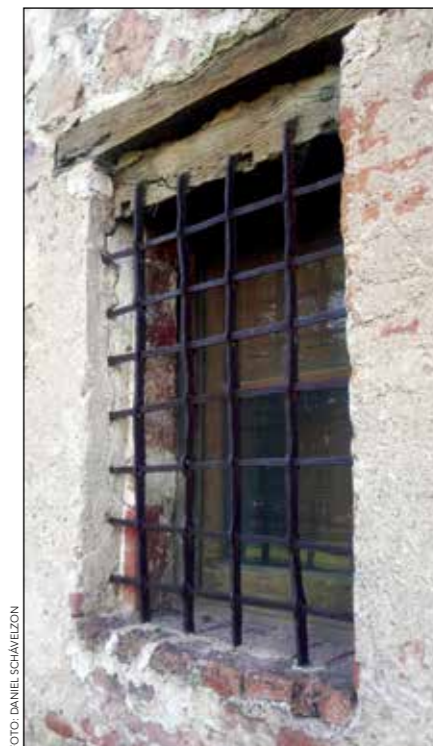
Reja de ventana del siglo XVII mal colocada en la restauración en el convento de Alta Gracia, Córdoba, Argentina. Nótese el sistema usado para unir los verticales con los horizontales.
