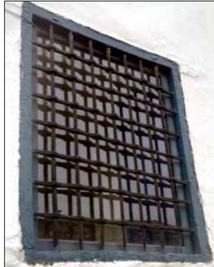
Dos ventanas coloniales tempranas en la ciudad de Cusco, Perú, con soluciones similares para el cruce de los barrotes y su refuerzo.
