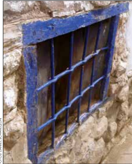
Dos ventanas coloniales tempranas en la ciudad de Cusco, Perú, con soluciones similares para el cruce de los barrotes y su refuerzo.
