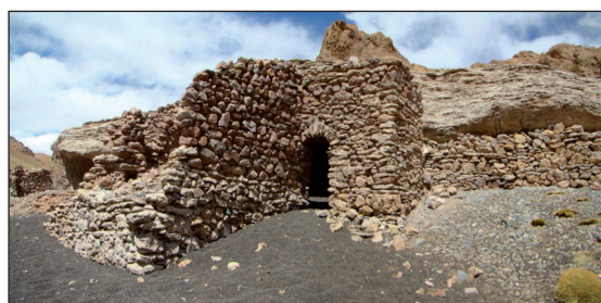
Figura 3: Vista de la estructura con vanos en arco presente en Casablanca, posiblemente construida como parte de un molino accionado por fuerza hidráulica.
