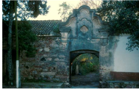
Fig. n°8: Ingreso al zaguán de la ranchería de Santa Catalina.
