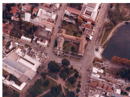
Fig. nº9: Vista a vuelo de pájaro señalando ubicación del obraje.
