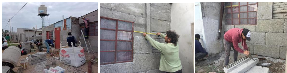
Figura 4: Imágenes del proceso de colocación de los paneles como revestimiento de una vivienda de planchones en barrio La Unión.
