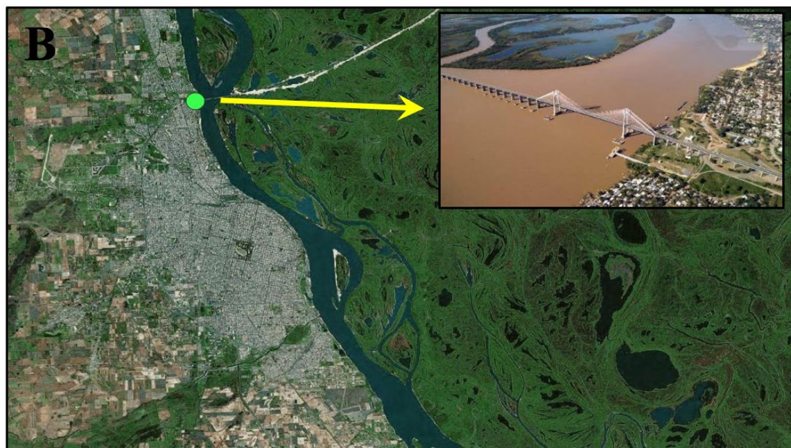
Figura 3. Tramo del río Paraná a la altura de la ciudad de Rosario. Puente Rosario-Victoria
