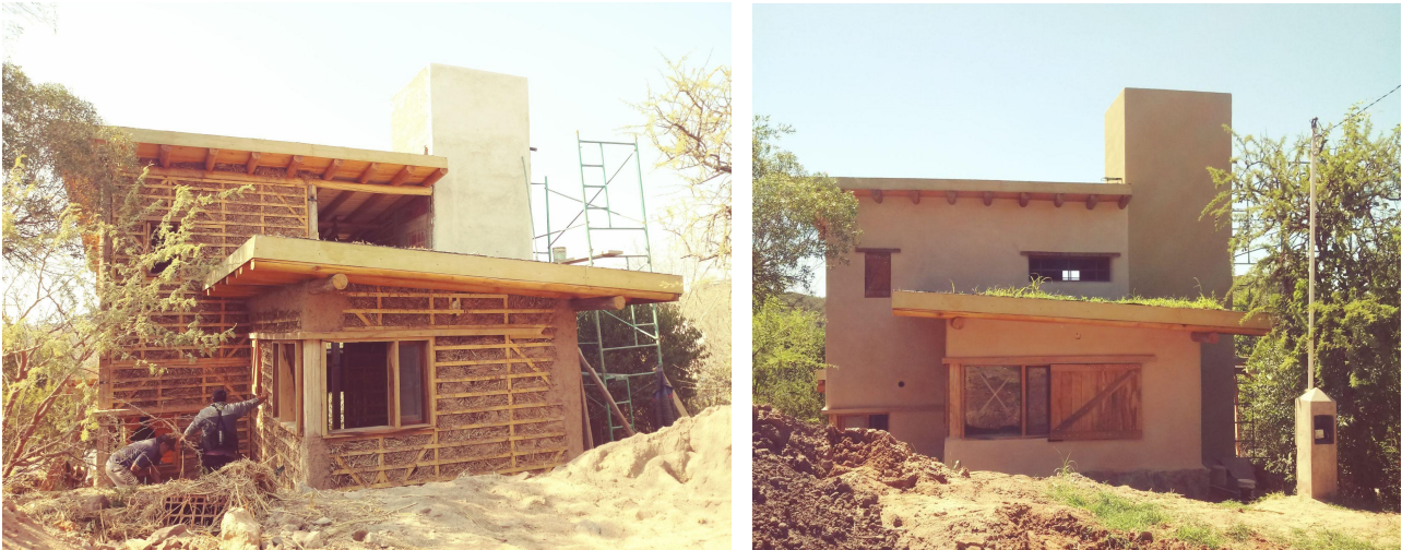
Fig.12. Vivienda construida con técnica de quincha. La Serranita, Córdoba, Argentina. Año 2020-2021. Fuente: María Rosa Mandrini
