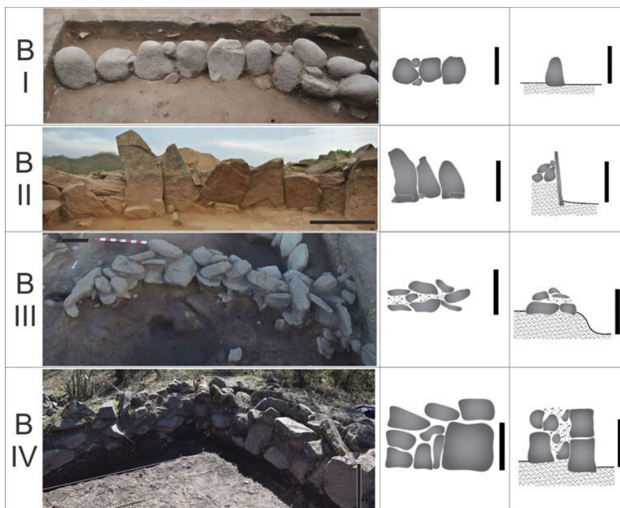
FIGURA 3. Cuadro donde se grafica la asociación hecha entre muros y bloques cronológicos prehispánicos. Puede verse de izquierda a derecha: Número de bloque; vista frontal de los muros; perfil frontal desde el interior; y la sección transversal. Escala, en todos los casos, equivale a 50 cm. (Salazar et al., 2021, p. 4)
