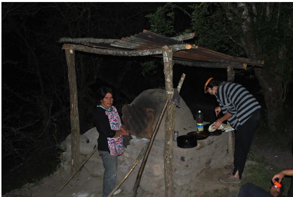
FIGURA 4. Imagen en la que puede observarse un horno de barro activo, con base de piedra y la techumbre de protección. Horno perteneciente a Susana Navarrete.
